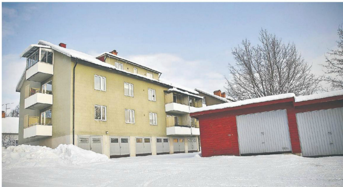
Länsstyrelsen har valt ut några flerfamiljshus, bland annat fastigheten Stenhamre 8:2 i Ljusdal, där ägarna ska få hjälp med förslag på energibesparande åtgärder.
